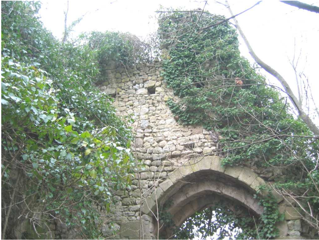
Foto n. 42: Particolare del portale
